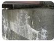
近接目視・写真撮影
